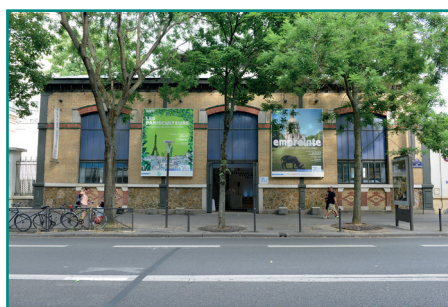
Pavillon de l'eau, Paris 16
